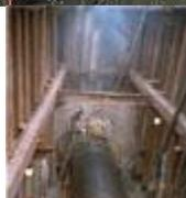
4. Спуск микрощита в подготовленный забой и фиксация его на прессовой станции
