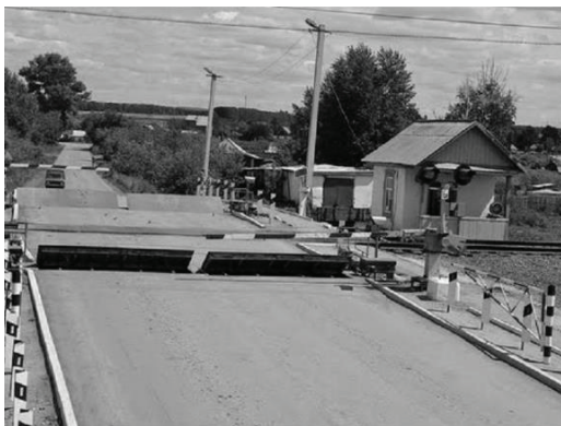
Рис. 2. Переезд, оснащённый шлагбаумом, светофором и УЗП
